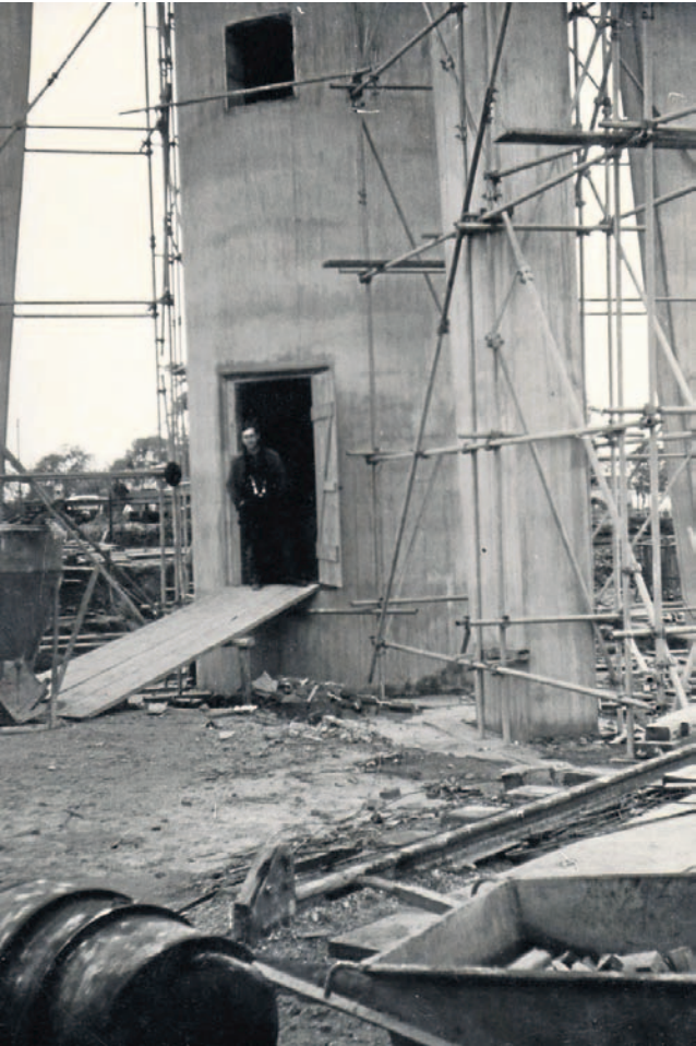
Die 1858 gegründete Wittener Baufirma Lünenbürger & Franzen zog den Wasserturm in die Höhe.
