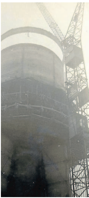
Mit einzelnen Ring-Elementen wuchs der Turm.
