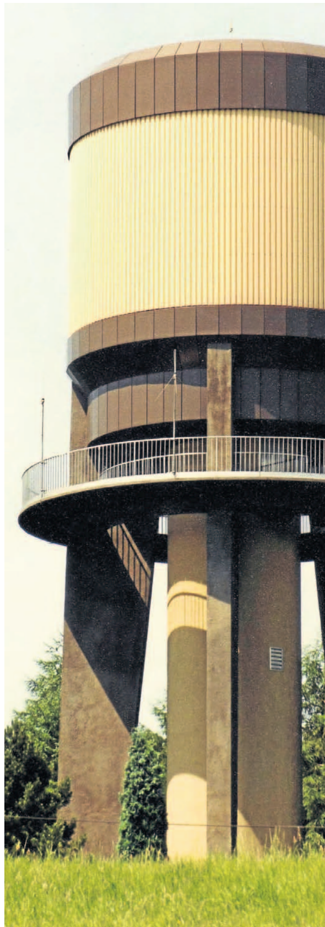
Der Wasserturm am Kermelberg ist 30 Meter hoch und hat ein Fassungsvermögen von 300 Kubikmetern. Im März 1959 wurde er eingeweiht. Er versorgt den Ortsteil „Auf dem Schnee“ mit Trinkwasser. Fotos (9) Sammlung König
