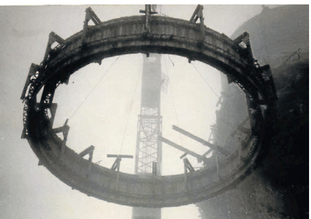
Bauteil für Bauteil wurde am Riesenkran in bis zu 30 Meter Höhe geschafft.
