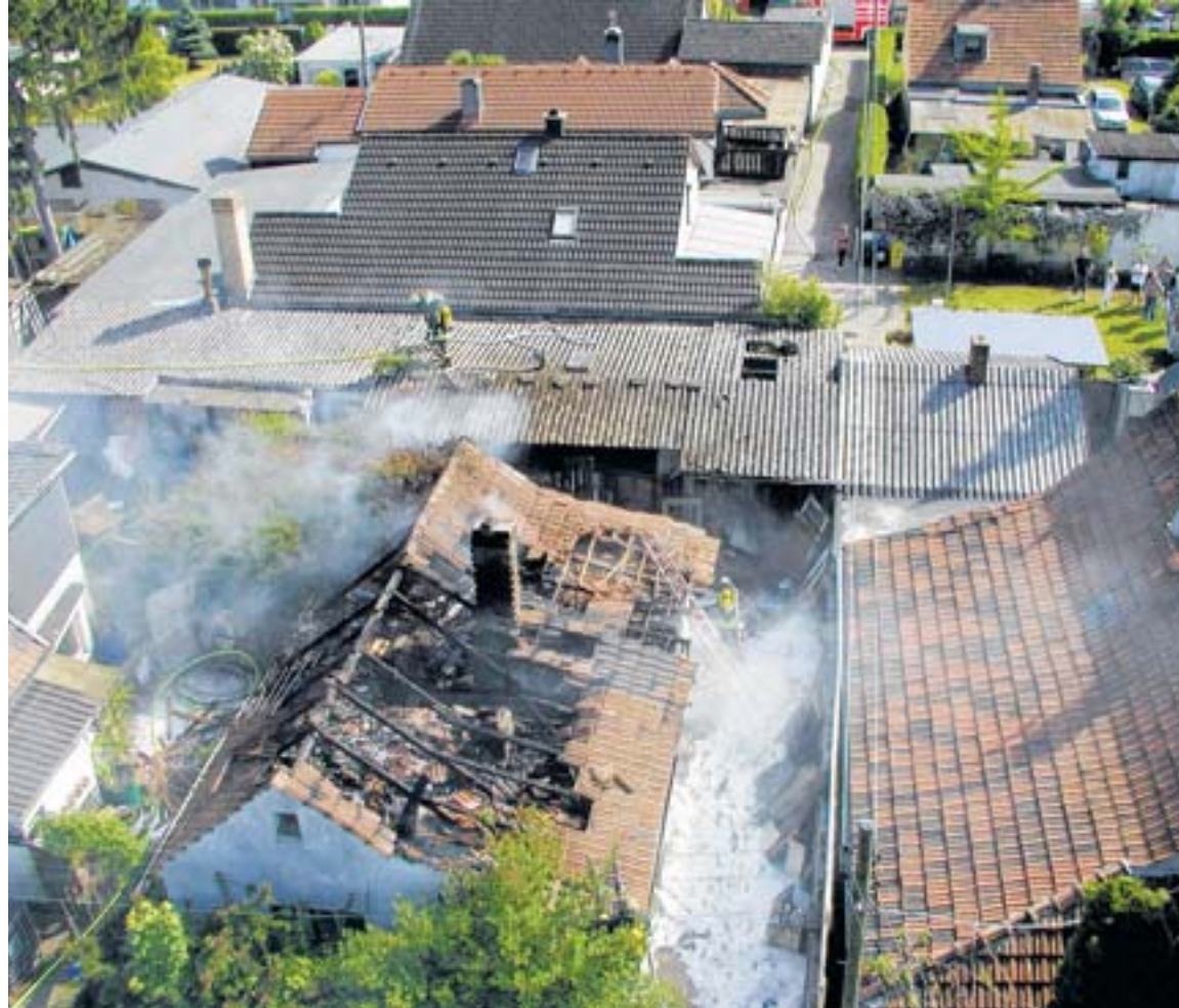
Das seit Jahren unbewohnte Haus am Löwenzahnweg kurz nach dem verheerenden Feuer am Samstag: Durch fliegende Funken geriet das Dach eines weiteren Gebäudes in der Siedlung in Brand. FOTO: FEUERWEHR DÜSSELDORF
