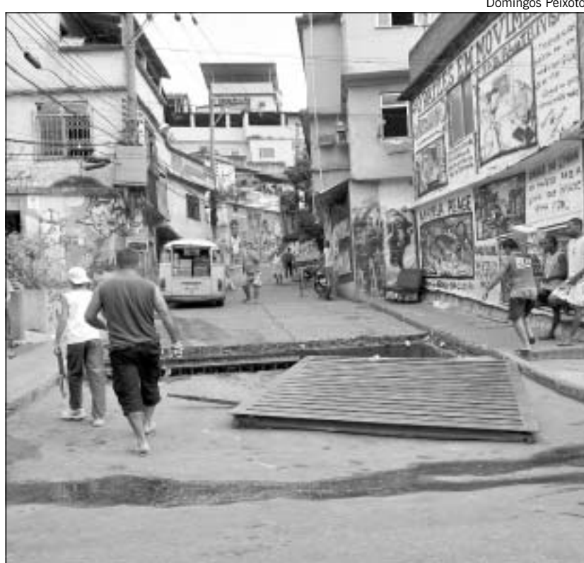
PISTA BLOQUEADA: num acesso à Grota, a grade retirada de uma vala de esgoto
